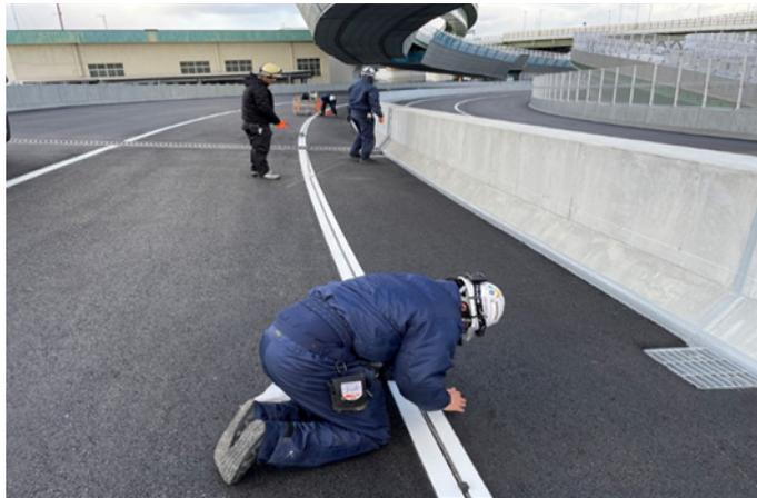
アスファルト舗装内部へ光ファイバを敷設する様子
