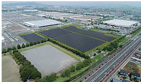
自家消費としては国内最大級の太陽光発電設備の導入を計画 群馬製作所大泉工場は、太陽光エネルギーの導入で、よりクリーンな工場を目指す（写真は大泉工場太陽光発電設備完成予想図）
