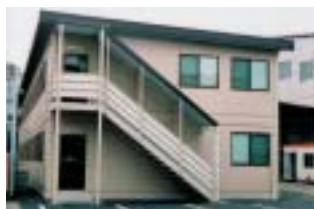
7月25日に完成引渡しが完了した群馬製作所第一製造部事務所棟（CAB型二階建事務所タイプ）
