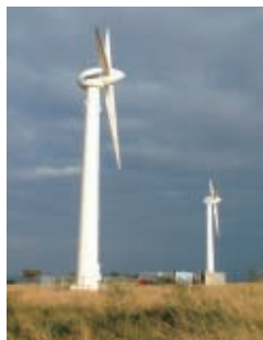
NEDO（新エネルギー・産業技術総合開発機構）から開発委託された離島用風力発電システム。沖縄県伊是名島に建設し実証試験を行った結果、4年間に渡る開発を完了。
