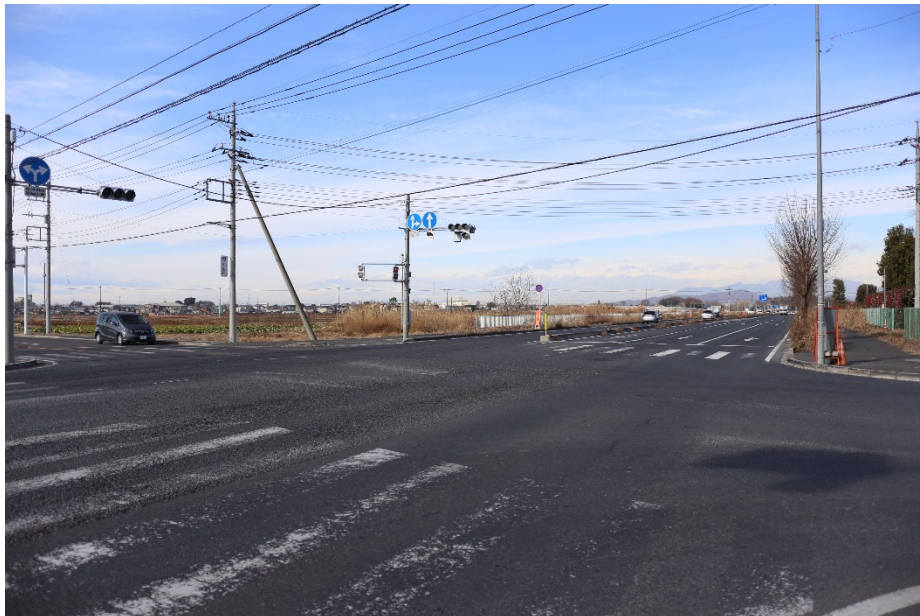
写真 6. 9-2 No.2 計画地東側（一般国道 354 号・交差点）
