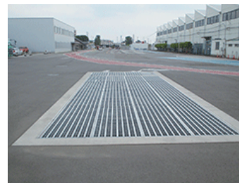
浸水対策（排水口）（宇都宮製作所）
