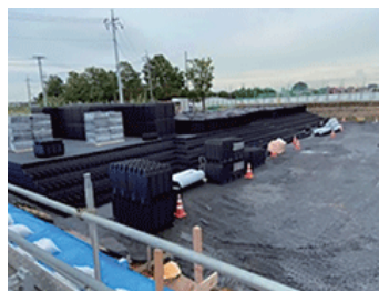
雨水貯留槽設置工事
