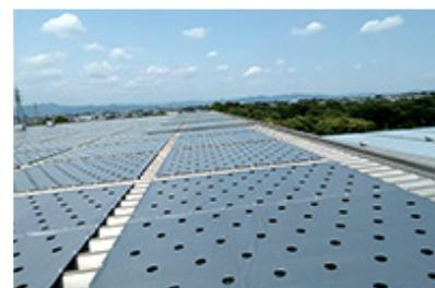
工場屋根への断熱シート張り付け
