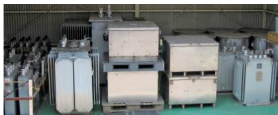
法規に基づいてPCB含有機器を保管(宇都宮製作所)
