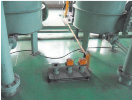
循環水ピットのオーバーフロー防止のために取り付けられた水位センサー（エコテクノロジーカンパニー）
