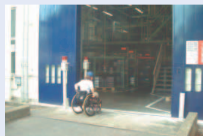
スロープ化され、自動ドア化された工場入り口（大泉工場）
