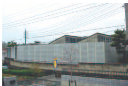
防音塀の設置 （群馬製作所大泉工場）
