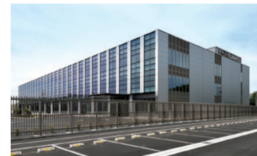
「管理棟本館」外観
